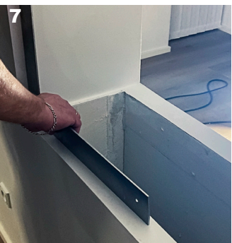
7 Alle krydsmaal skal være i vinkel / All cross-measures must be at an angle.
