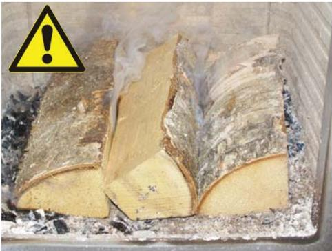
Hier ist Holz auf eine zu geringe Glutschicht gelegt worden und es wird zu wenig Luft zugeführt – die Rauchentwicklung beginnt.
