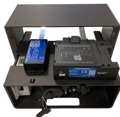
Petite grille d'inspection - intérieure
