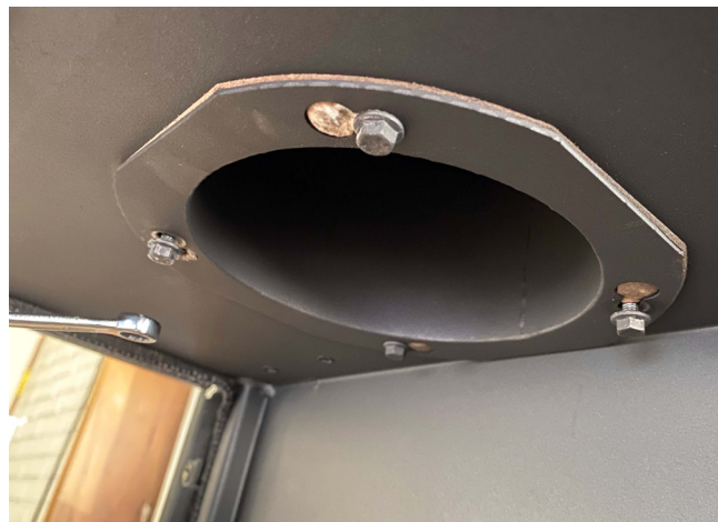
1. Desserrez deux des boulons en diagonale.
